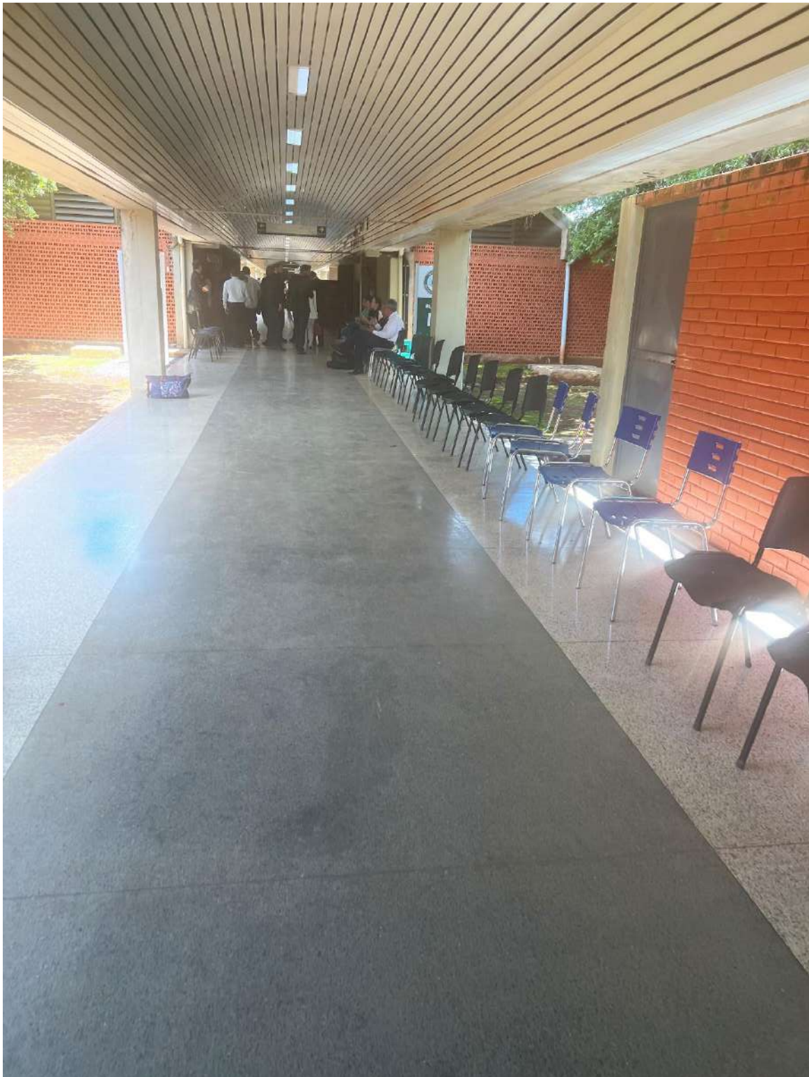
Figura 45. Corredor da parte interna.
