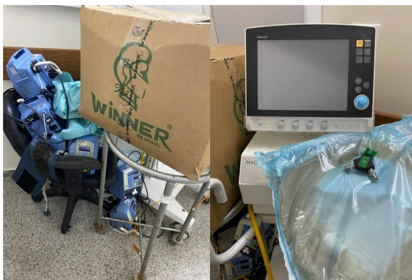
Figura 23 –Bombas de infusão e respiradores encontrados no final da ala da UCI;
