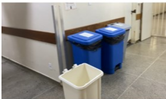
Figura 29 – Lixeira aberta coletando água de goteira no corredor de fora da UGI ala masculina
