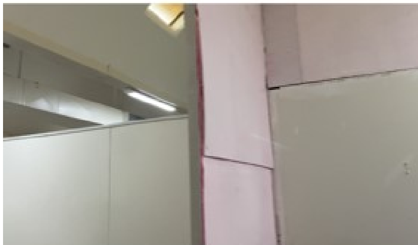
Figura 34 –Vedação improvisada com tapume do isolamento 2;
