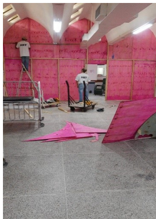
Figura 45 – Instalação dos tapumes para abrir ala Covid 2 no PS
